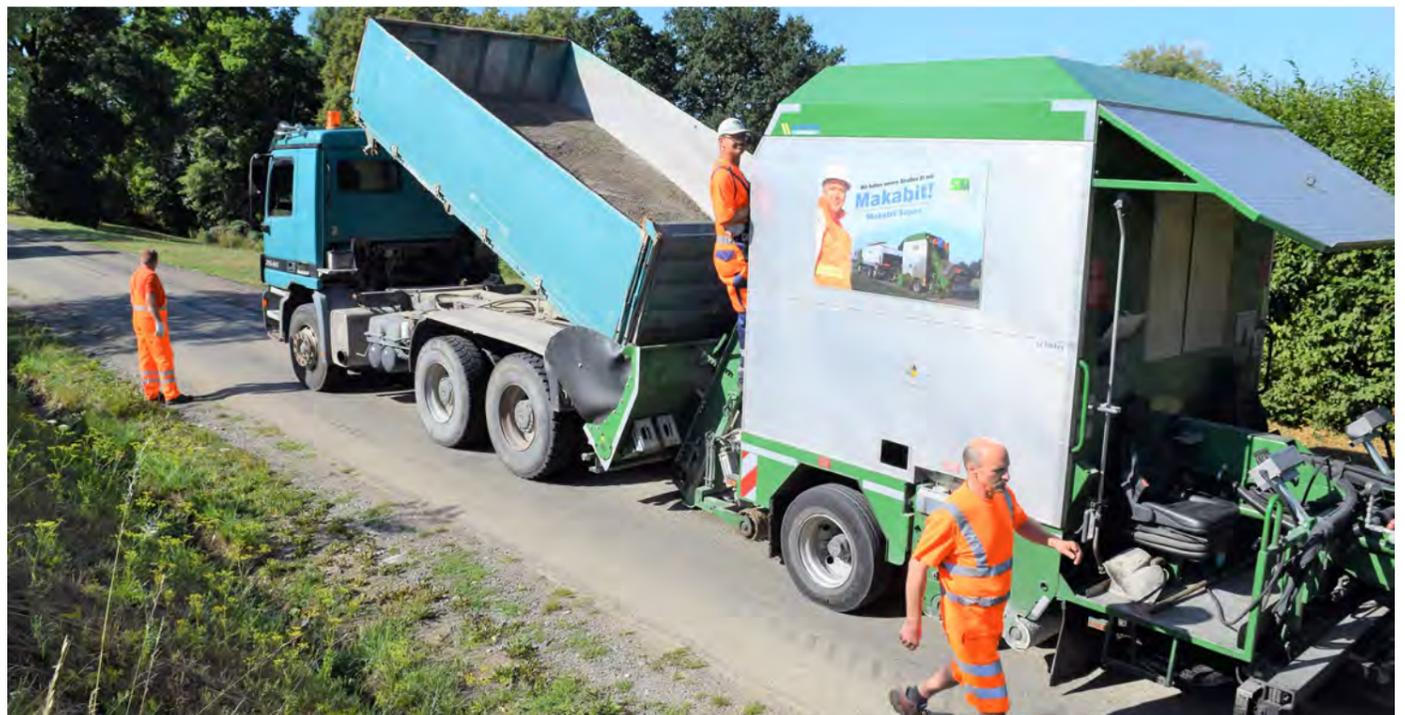
Sanierungs- und Erhaltungsarbeiten mit dem STM-Reparatur-Zug
