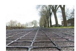
Vor dem Einbau ist die Ebenheit der Verlegefläche zu überprüfen und der Untergrund zu reinigen. Sollten hierbei Risse, Fugen oder andere Öffnung zum Vorschein kommen, sind diese zu vergießen.
