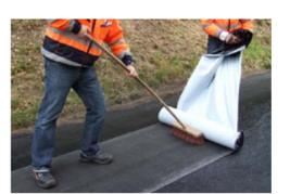
Das Asphaltgitter ist bei trockener Witterung, faltenfrei in die gebrochene Bitumenemulsion zu verlegen.
