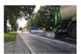
Unmittelbar vor dem Verlegen der Asphaltbewehrung ist auf den sauberen und trockenen Untergrund eine polymermodifizierte Bitumenemulsion der Güte C60BP4-S nach TL BE StB 15 aufzuspritzen. Die Lufttemperatur von 10° C und die Untergrundtemperatur 5° C darf während des Einbaus nicht unterschritten werden.
