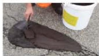
Ausgleichen von Absenkungen mit Reparaturmörtel E \*
